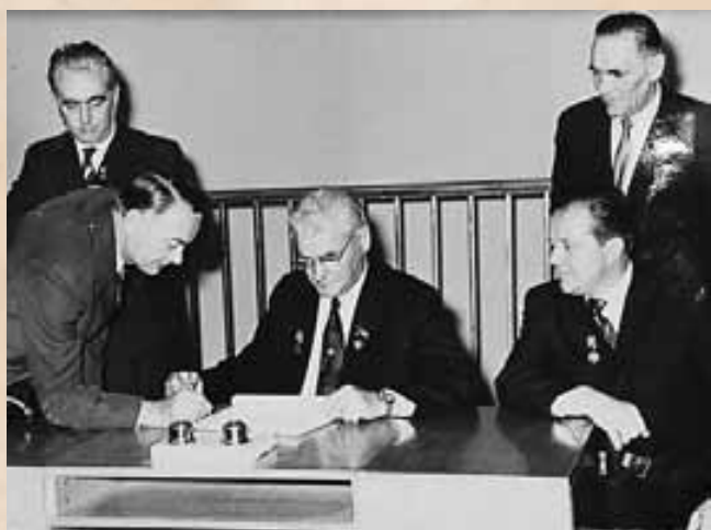
Министр энергетики СССР П.С. Непорожний и директор Лукомльской ГРЭС Г.Н. Хартанович подписывают соглашение на поставку оборудования для строящейся ЛГРЭС, 1963 год
