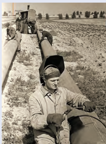
Лучший электросварщик управления №130 В. Коробейников на строительстве газопровода в Гомеле, 10 июля 1959 года
