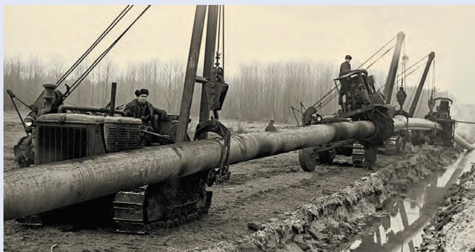
Укладка газопроводных труб в окрестностях Гомеля, 26 декабря 1960 года
