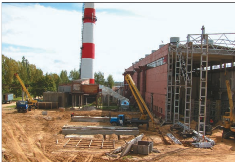
РК-3 на первоначальном этапе реконструкции...
