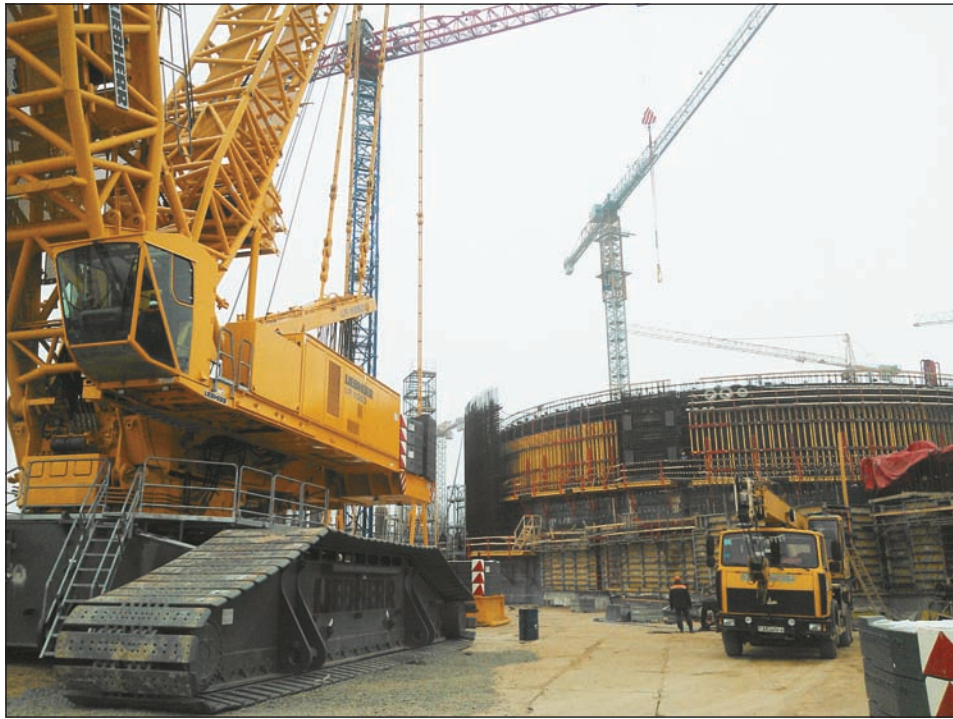
Так сегодня выглядит надземная часть реакторного отделения первого энергоблока Белорусской АЭС
