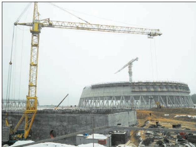
Строительство гравирни будущей Белорусской АЭС
