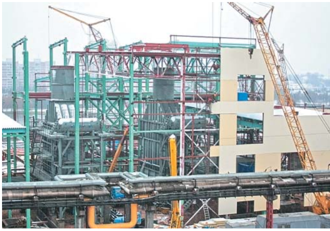
Строительство корпуса котельного отделения Минской ТЭЦ-2
