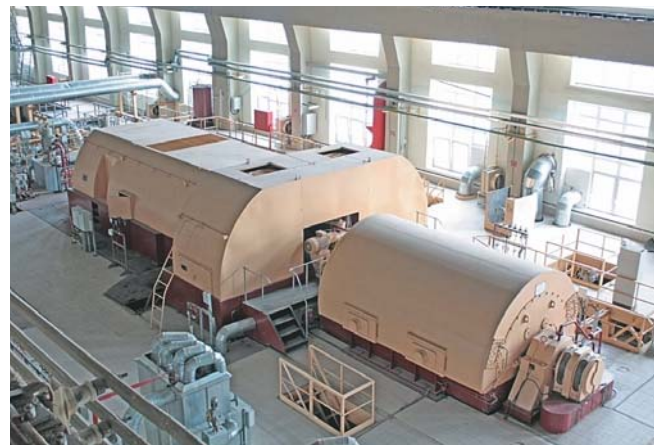
Турбина Т-53/67-8,0 в турбинном отделении Минской ТЭЦ-3
