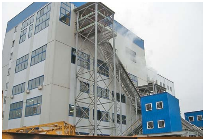
Жодинская ТЭЦ. Здание котельного отделения, в котором установлен котел E-60-9,5-510 ДФТ
