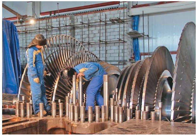
Монтаж ЦНД паровой турбины ТЭЦ-5
