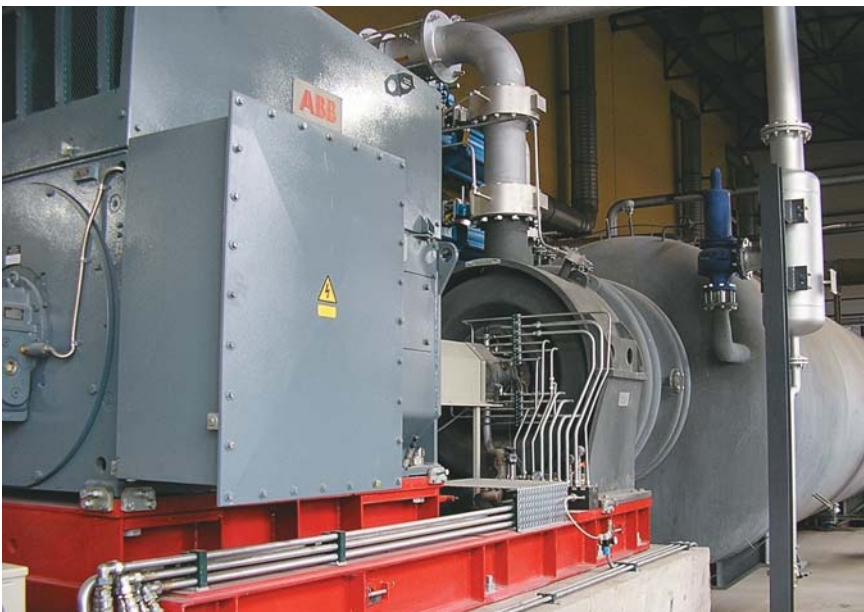
Рис. 1. Общий вид ORC-модуля Речицкой мини-ТЭЦ
