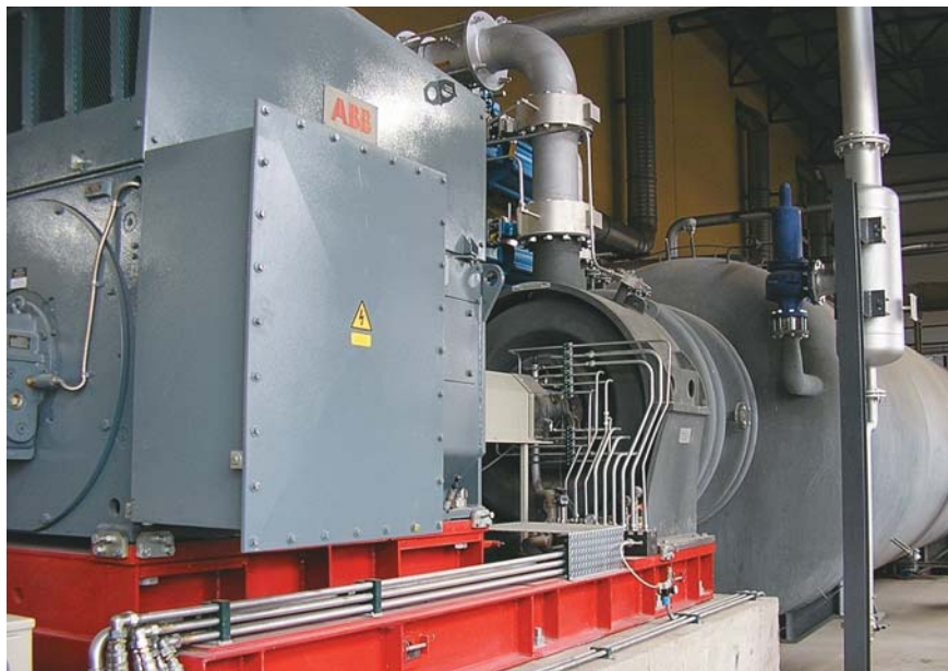
Рис. 1. Общий вид ORC-модуля Речицкой мини-ТЭЦ
