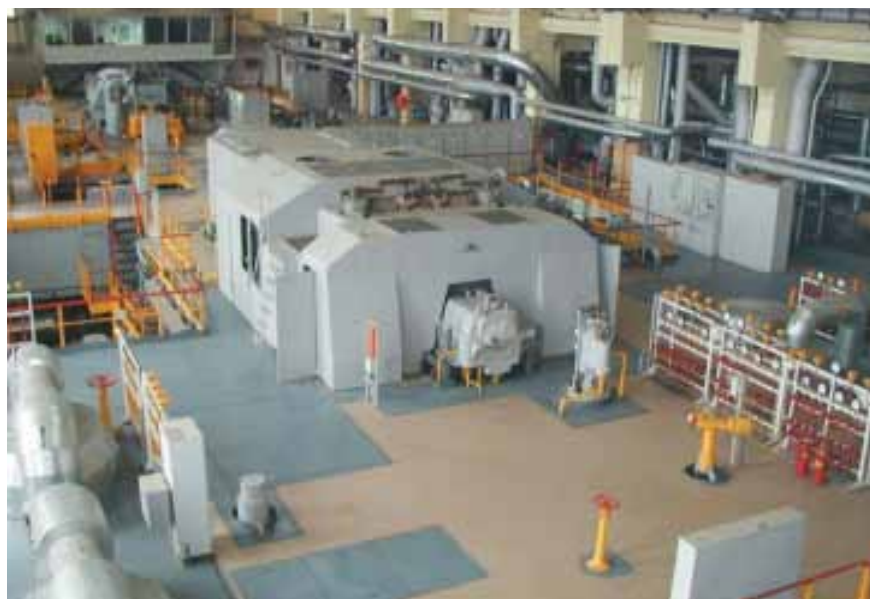
Витебская ТЭЦ. Турбинное отделение 2-й очереди. Турбоагрегат ПТ-3540-8.8 ст. № 3
