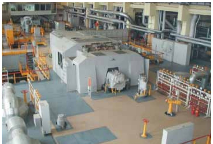
Витебская ТЭЦ. Турбинное отделение 2-й очереди. Турбоагрегат ПТ-3540-8.8 ст. № 3
