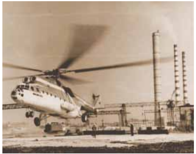
Монтаж дымовой трубы 2-й очереди
