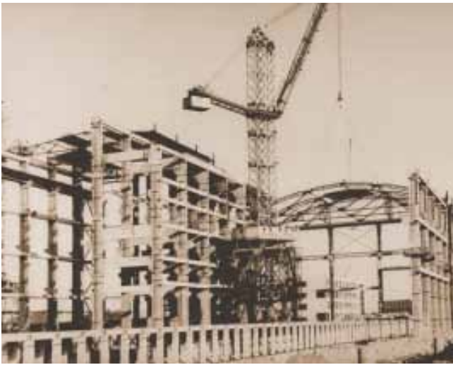
Монтаж главного корпуса
